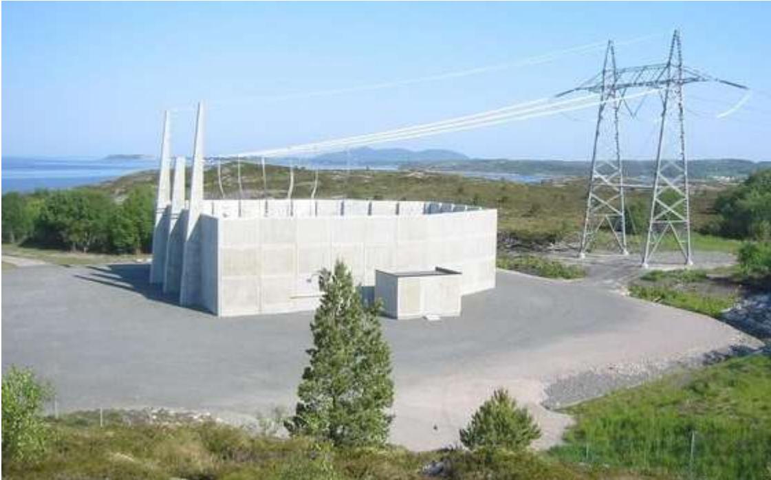
Figur 4-9. Eksempel på et muffeanlegg for et 420 kV anlegg for ledningen Fræna – Nyhamna, 420 kV (Teknisk ukeblad, 2010)
